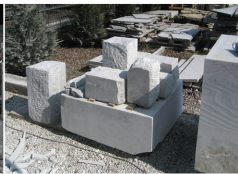
März 2011 [Abtragung/Sicherung kleiner Blöcke]
